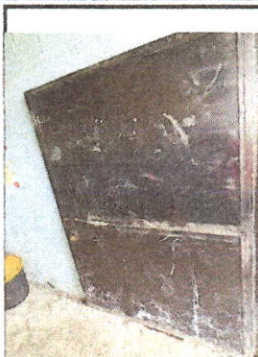
Sustitución de puertas de metal INEB Telesecundaria El Pato.
