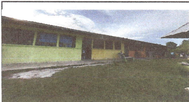
Pintura interior y exterior INEB Telesecundaria El Pato.
